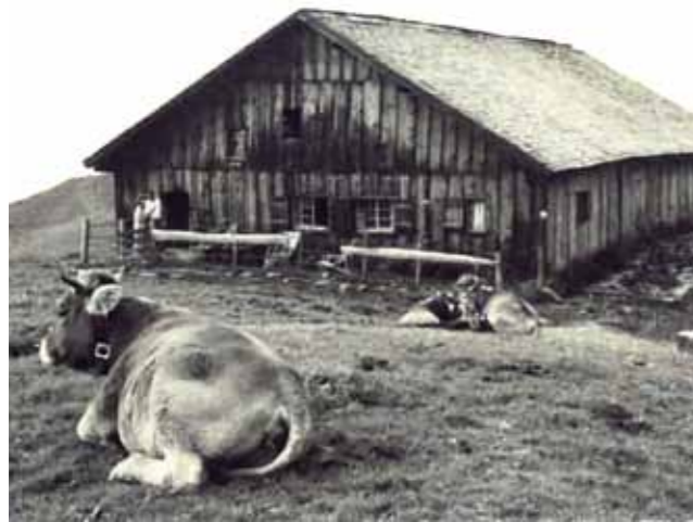
Alte Aphütte bis 1966
